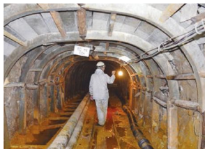
花輪鉱山 坑道点検の様子
