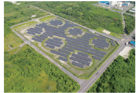
下松メガソーラー発電所
