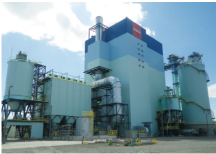
室蘭バイオマス発電所
