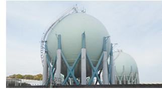
球形タンクのブレース（筋交い）補強
