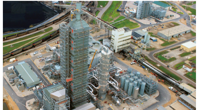
CO 2 回収プラント（米国テキサス州）
